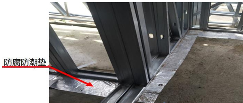
图 8.2.1-2 底导梁和基础之间设置防腐防潮垫
